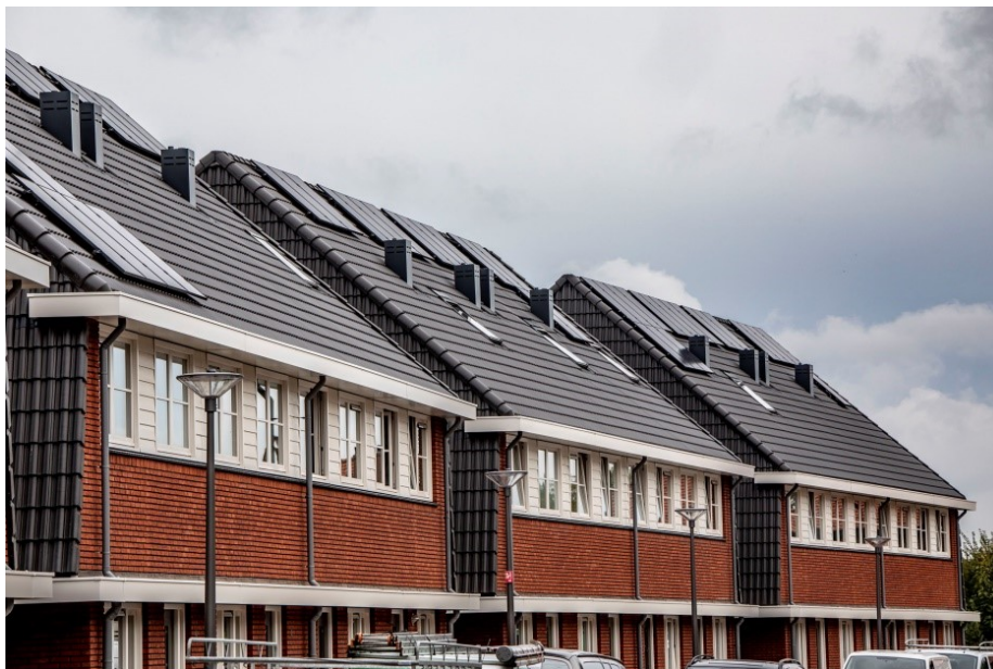
Foto 3.1 Nieuwbouw aan de Fossastraat (Hoogeland, Naaldwijk)
