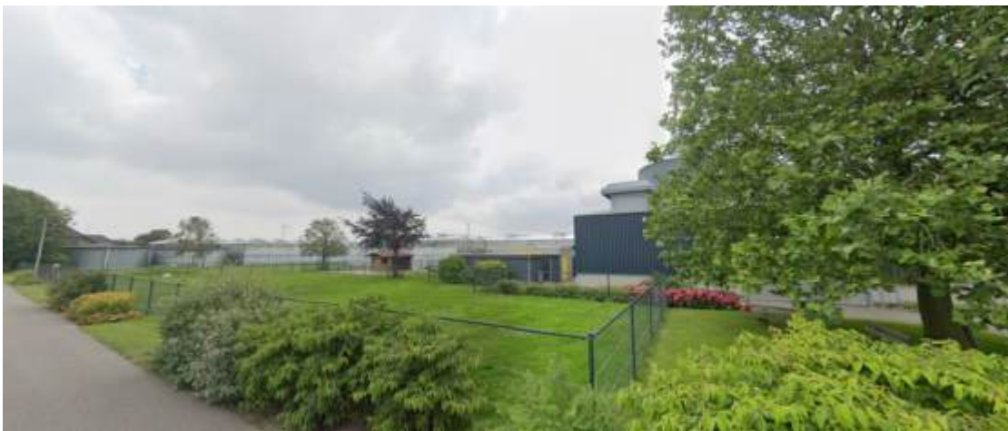
Projectlocatie vanaf de Oranjepolderweg
